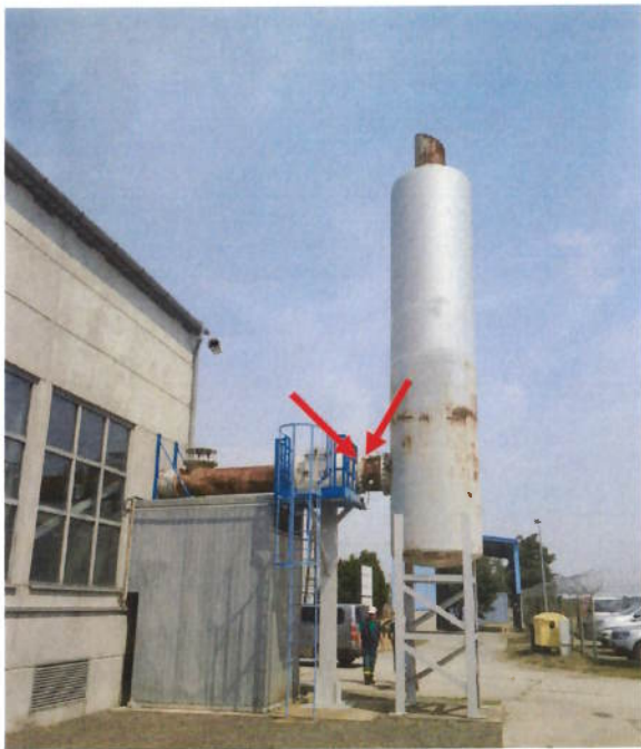
Obrázok č. 1 Stredisko Gajary Báden - pohľad na spalínovod a komín - Piestový kompresor, vyznačenie meracích miest
