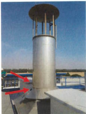
Obrázok č. 1 Pohľad na komín turbokompresora TK1/4, vyznačenie meracích miest
