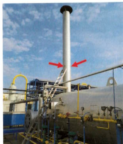
Obrázok č. 5 Pohľad na komín kotla OH2B, vyznačenie meracích miest
