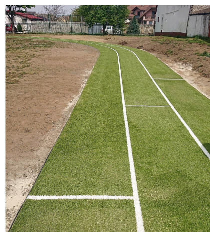
• Rekonštrukcia bežeckej trati
