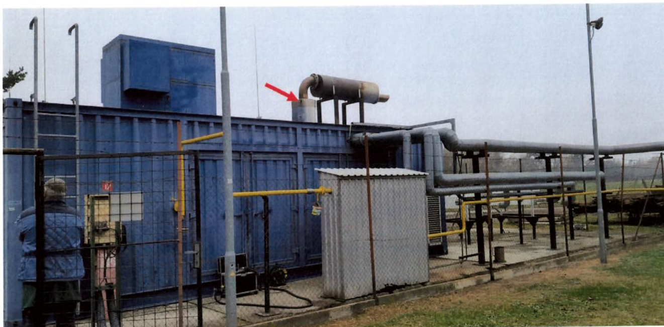
Obrázok č. 1 Pohľad na kontajner KGJ s vyznačeným meracím miestom ←
