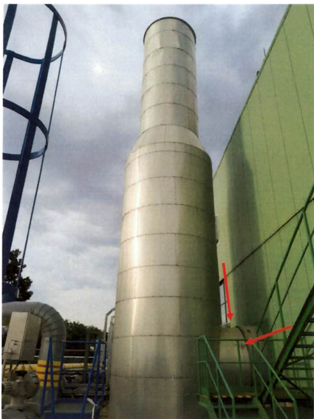
Obrázok č. 1: TK7 – spalinovod a komín, umiestnenie meracích miest
