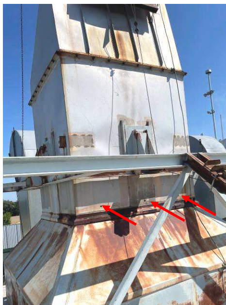
Obrázok č. 2: Typické umiestnenie meracích miest na príklade TK1
