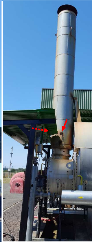
▲ Obrázok č. 10 Stredisko ZS3 – kotol OH 320, vyznačenie meracích miest
