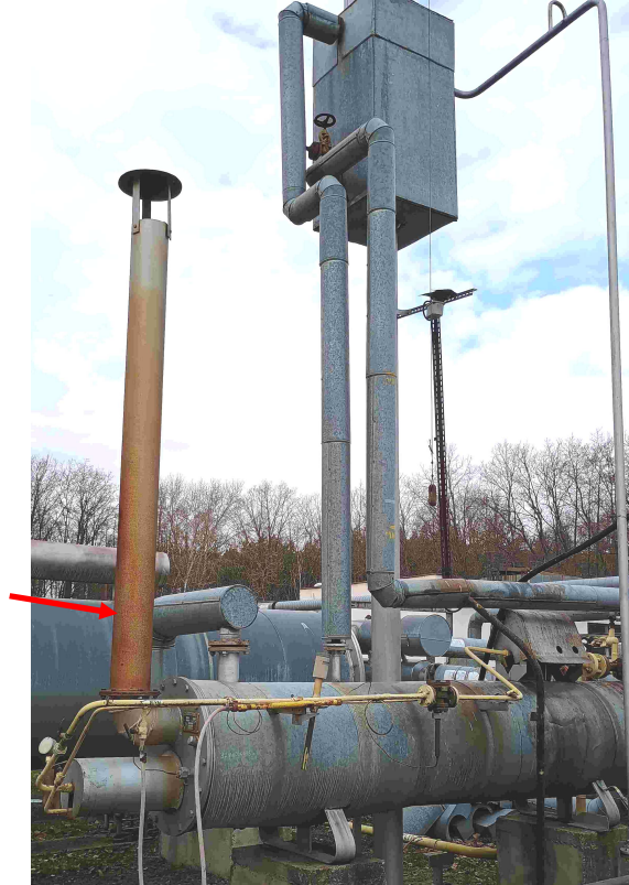
Obrázok č. 2 Stredisko ZNS Veľké Leváre – kotol K03, vyznačenie meracieho miesta ←
