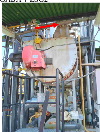
Obrázok č. 4 Pohľad na komín kotla RK350 , vyznačenie meracích miest – ZS3
