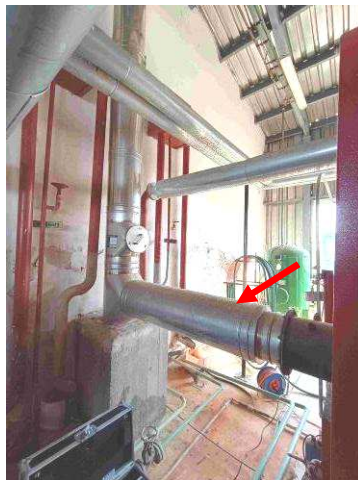
Obrázok č. 2 Pohľad na komín kotla K3 , vyznačenie meracích miest – GABA + ZSG2
