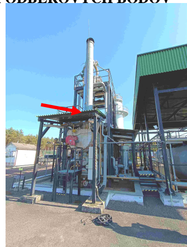
Obrázok č. 3 Pohľad na komín kotla RK , vyznačenie meracích miest – ZS2
